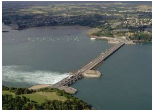
Barrage, France 240 MW
